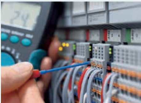
借助测试连接，即使在工作时，也可对安装进行直接验证
